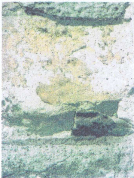
1. Pozostałości powłoki malarskiej oryginalnej tynku i detalu
